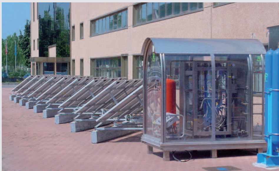
Stazione di produzione e caricamento idrogeno per motori a idrogeno (fuel cells) (elettrolizzatore Erreuegas, Italia; pannelli Solterra, Svizzera)
